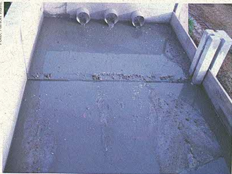
Figura 19. Caixa de areia com deposição de sólidos fixos para tratamento de dejetos de suínos.
