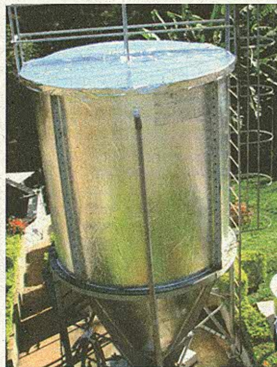
Figura 9. Reator Upstream Anaerobic Sludge Blanket (UASB) utilizado no tratamento de efluentes da suinocultura.
