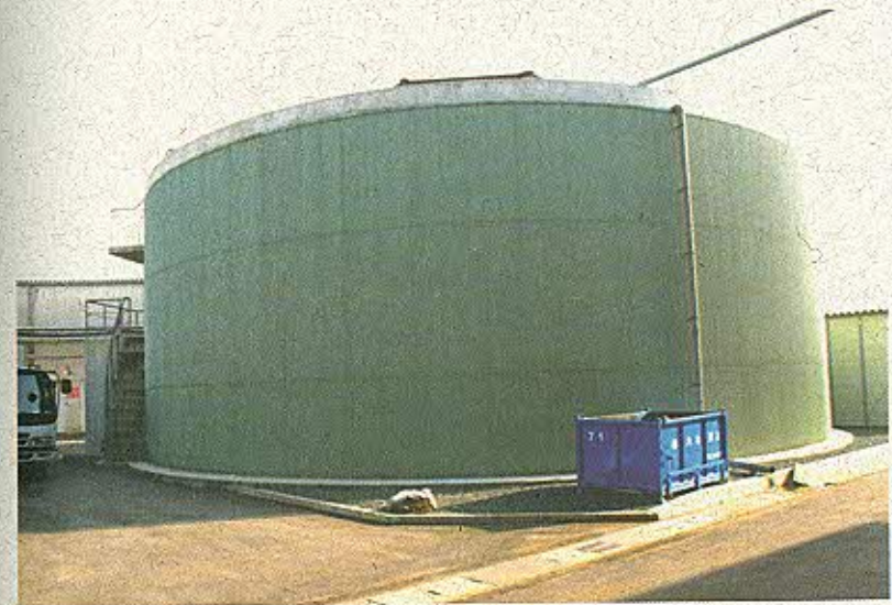
Figura 12. Biodigestor de mistura completa para processamento de resíduos animais e vegetais.
