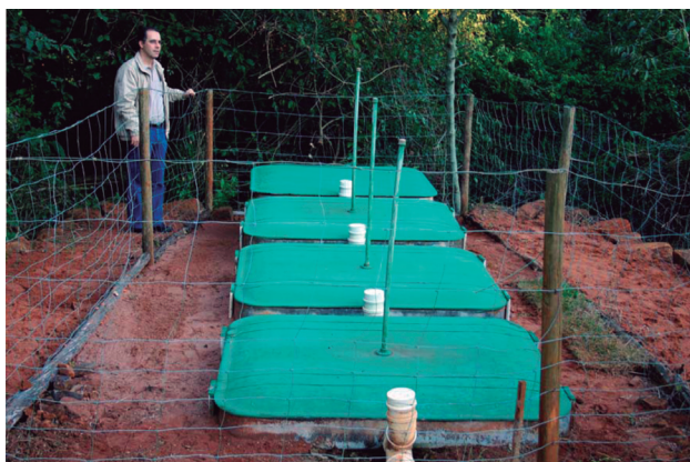
Figura 2 – A Fossa Séptica Biodigestora, desenvolvida pela Embrapa Instrumentação, é importante aliada na preservação ambiental e de fácil acesso para agricultores familiares
