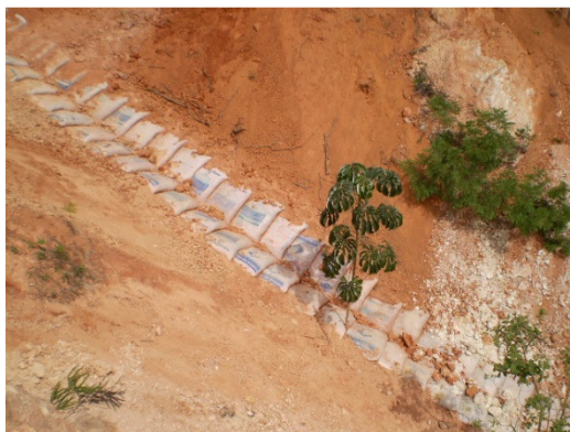
Figura 4: Drenagem interna da voçoroca com sacaria de solo-cimento.
