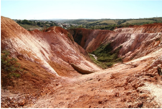
Figura 6: Retaludamento mecânico da voçoroca com escavadeira hidráulica.
