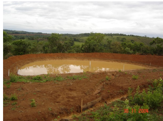
Figura 3: Barragem com diâmetro de 5 metros.
