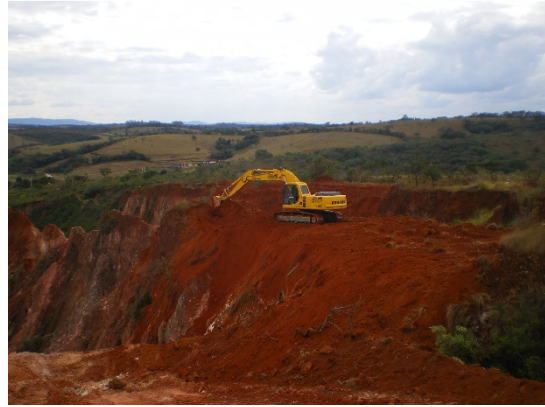
Figura 7: Retaludamento mecânico com escavadeira hidráulica.
