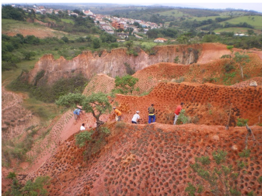
Figura 10: Coveamento e plantio nos taludes internos da voçoroca.
