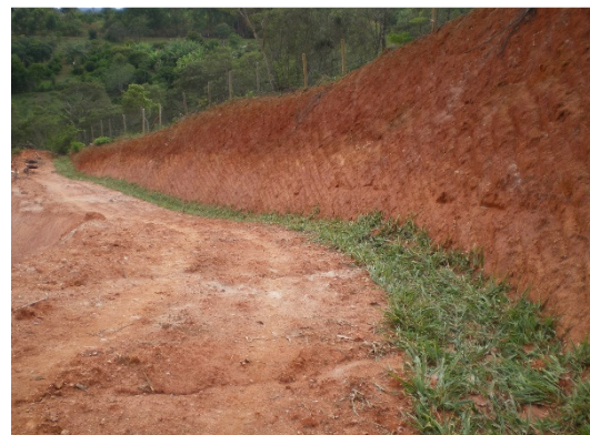
Figura 5: Drenagem interna do talude com placas de braquiária.
