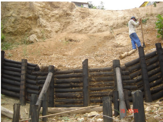
Figura 8: Paliçadas (cortinas de estacas justapostas)
