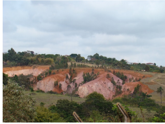
Figura 19: Voçoroca retaludada.
