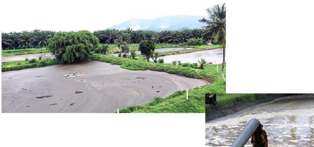
Figura16: Lagoa estacionária de efluentes gerandos no processamento e obtenção do oleo de palma (POME – Palm Oil Mill Effluent ).
