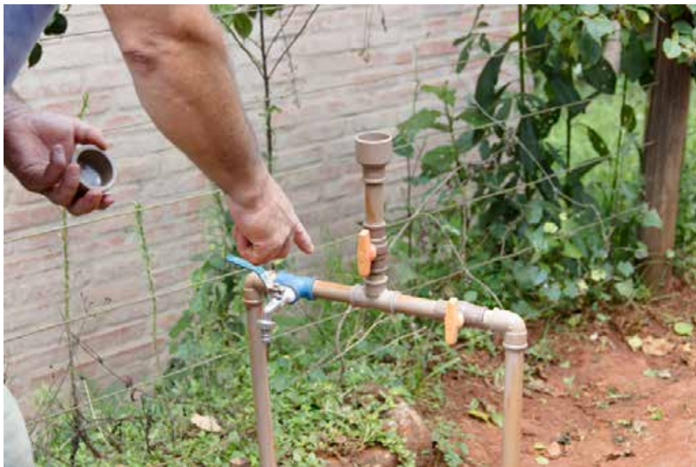
Figura 11. Clorador de fácil montagem e baixo custo.
