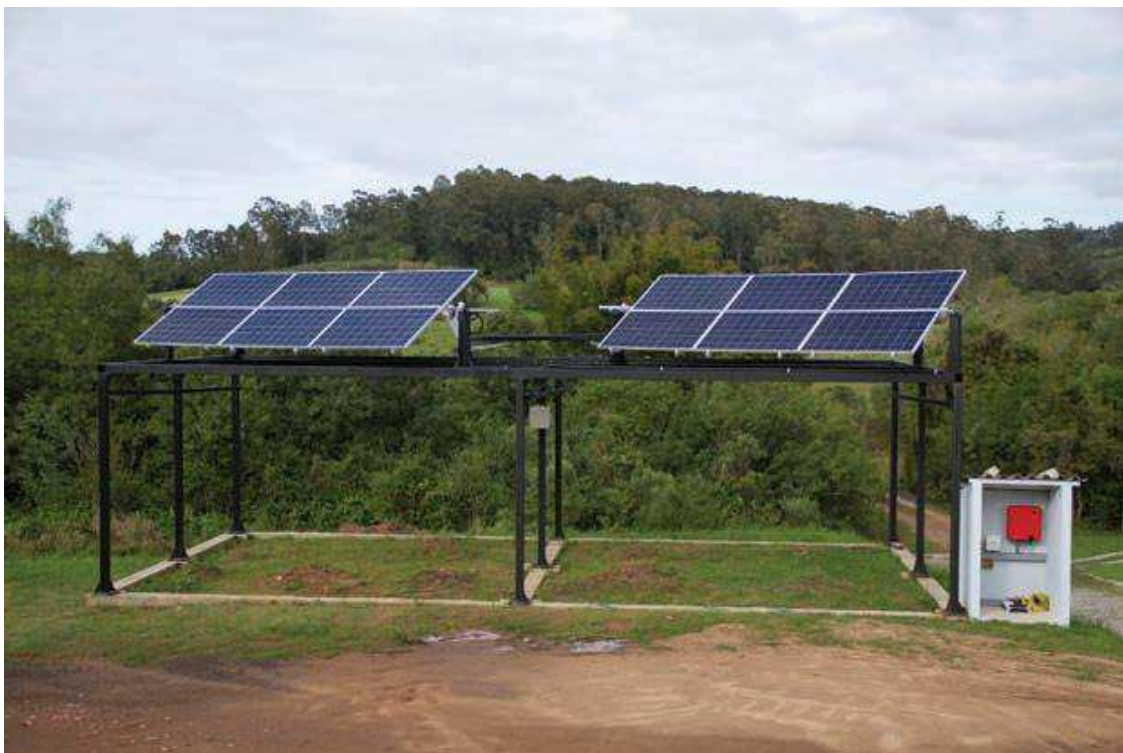
Figura 2. Sistema de geração de energia elétrica fotovoltaica com sistema seguidor solar instalado na Embrapa, EEC. Pelotas-RS, 2018.
