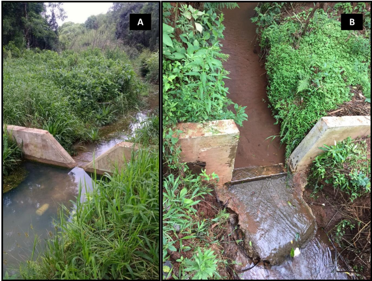
Figura 5: Vertedouros de alvenaria do tipo triangular (A) e retangular (B).
