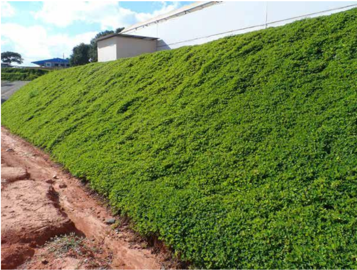
FIGURA 3 - Exemplo da utilização da grama-amendoim na contenção de encosta. Foto: Julcécia Camillo
