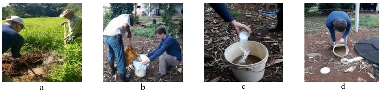
Figura 2. Imagens da inoculação da Fossa Séptica Biodigestora com sedimento de brejo. (a) coleta do material, (b) filtragem, (c) colocação de sal de cozinha e (d) colocação do líquido no sistema.
