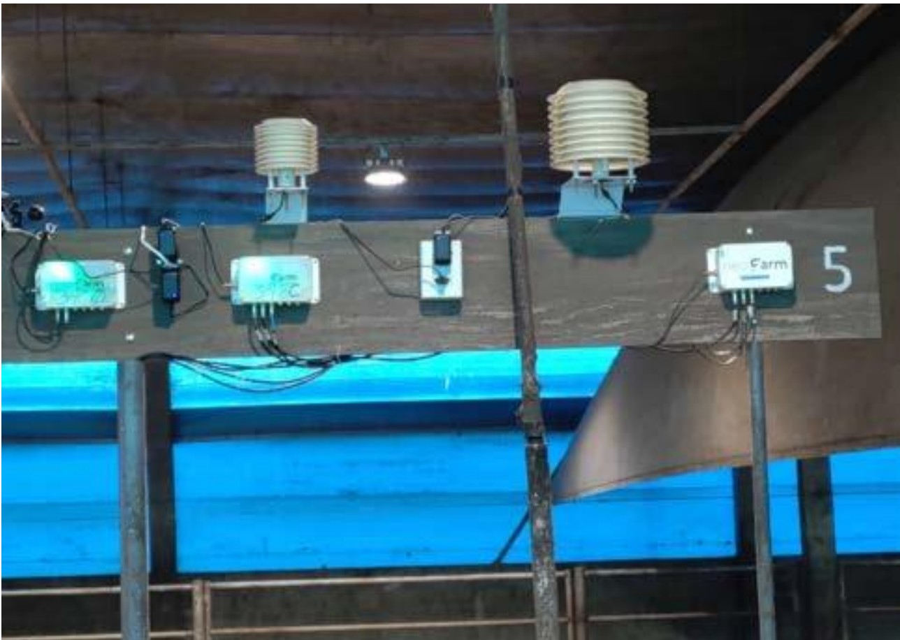
Figura 1. Instalação do dispositivo sobre o bebedouro.
