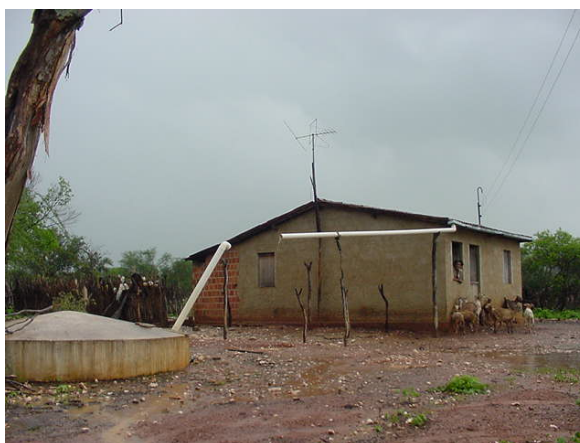
Figura 1. Residência com cisterna na comunidade de Varginha (Petrolina - PE), com calha incompleta.
