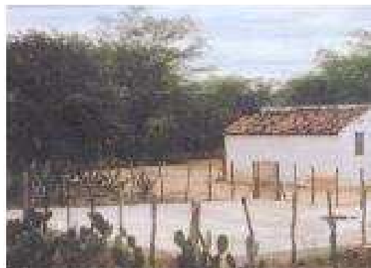
Cisterna tipo calçadão, com a área de captação no solo (Farias Júnior et al. 2003)
