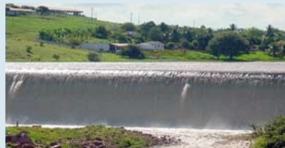
Fig. 4.5. Barragem com escoamento do excesso de água de chuva. (Foto: Nilton de B. Cavalcanti, 2005).
