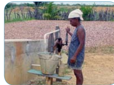
Fig. 4.2. Cisterna com área de captação no solo revestido com lona plástica e brita (Foto: Nilton de B. Cavalcanti, 2005).
