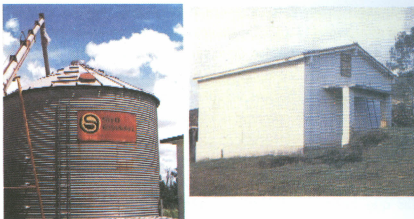
Figura 11.3. Silos para armazenagem na propriedade familiar.
