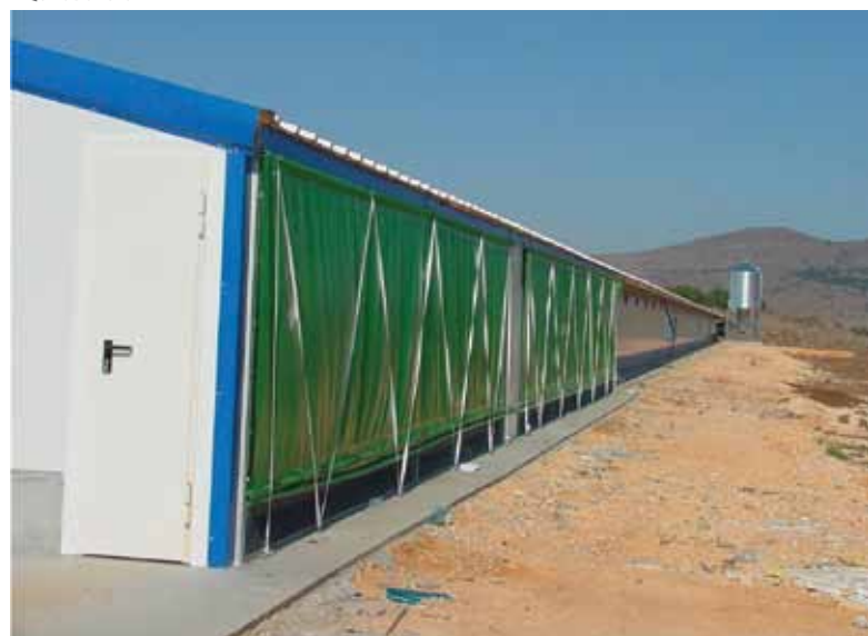
Figura 4. Visão externa de um galpão tipo "dark house"
