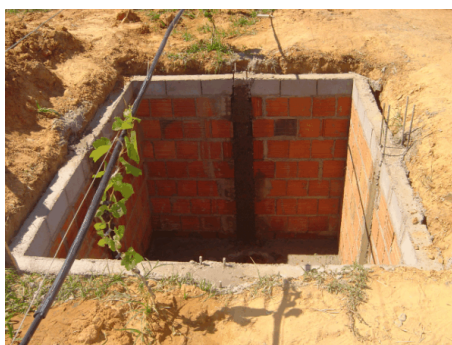
Figura 2. Parede de alvenaria com colunas de concretos para receber o sistema lisimétrico.
