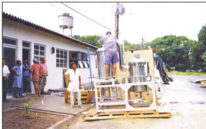
供与機材の荷ほどき、搬入作業
