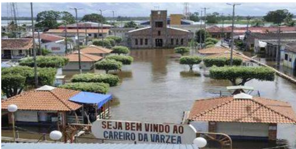
Figura 06: Sede do Município Careiro da Várzea Fonte: Acervo de PONTES, Diego. 2012.
