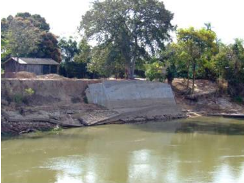
Figura 10. Muro de arrimo construído na tentativa de conter a erosão do barranco, em local sem área de preservação permanente no rio Paraguai, ao sul de Cáceres, registrado em 2008. Notar que esta estratégia mostra-se ineficaz.
