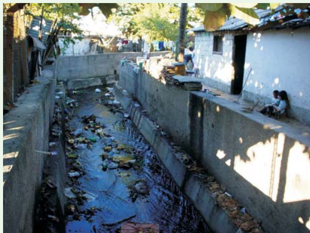
Água de drenagem exposta: risco de poluição.
