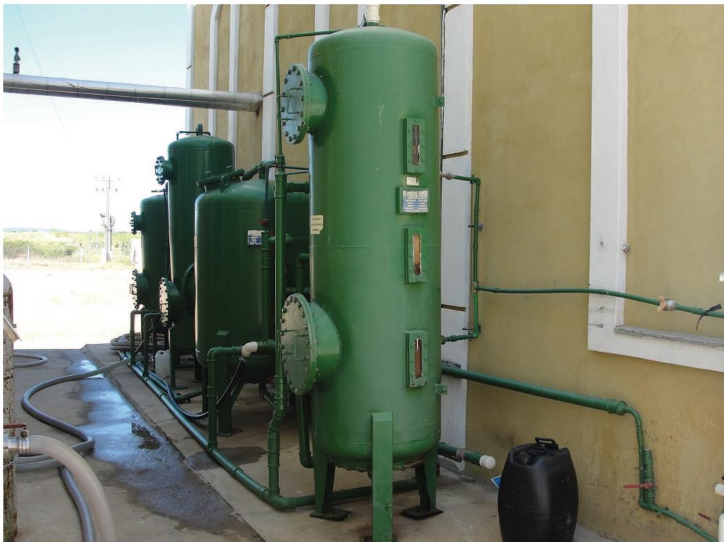
**Figura 6.** Exemplo de instalação para tratamento de água.
