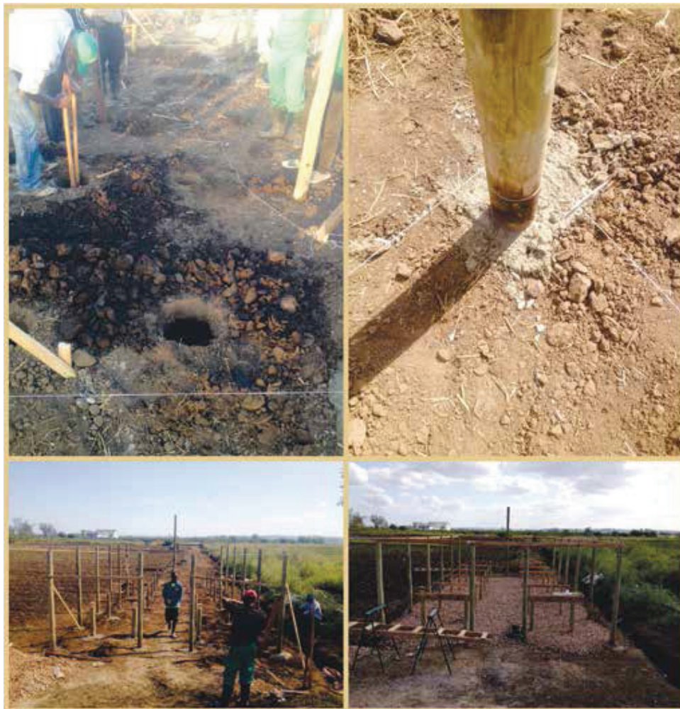
Figura 9. Instalação e esquadrinhamento das estruturas da estufa.
