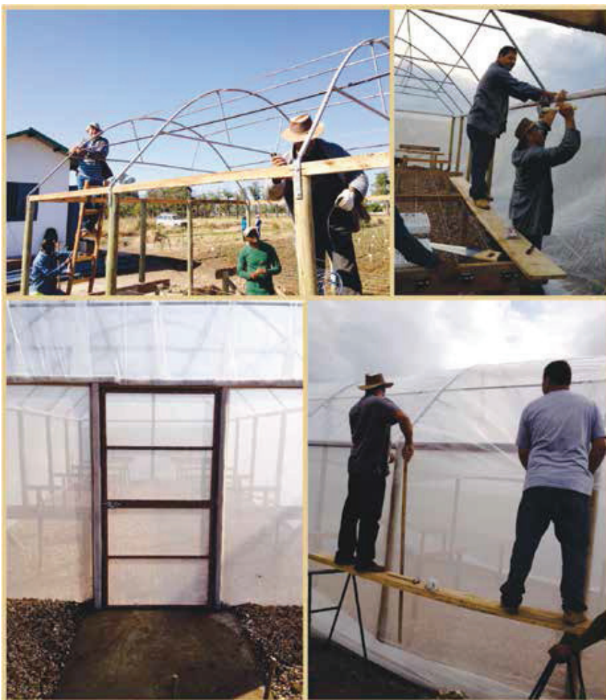
Figura 10. Detalhes da colocação dos arcos de ferro, plástico da cobertura, tela anti-afídeo, porta e colocação de brita no piso da estufa.
