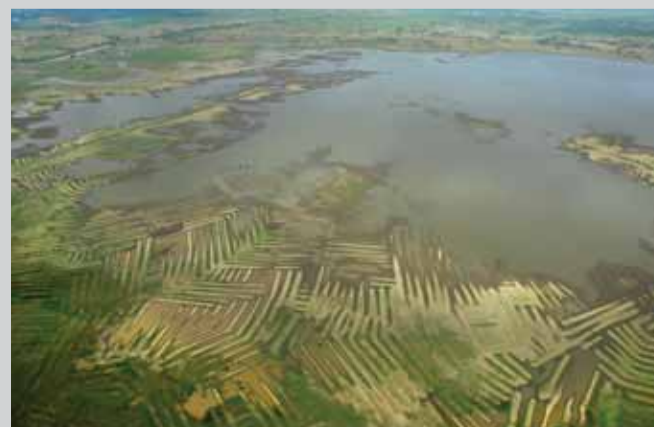
Vista atual dos canais artificiais construídos pela povoação dos indígenas zenúes para o controle de enchentes, melhoria da qualidade do solo e provisão de reserva de água para os períodos secos. A fotografia aérea ilustra os terraços elevados (linhas amarelas) separados por canais inundados (marrom). (MDO)
