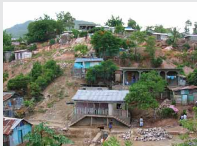
Erosão na zona de Bas-Ravine, parte norte do Cabo Haitiano. (RK)
