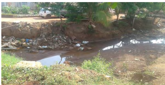
Figura 4. Assoreamento e acúmulo de resíduos trazidos pela água de enxurrada.
