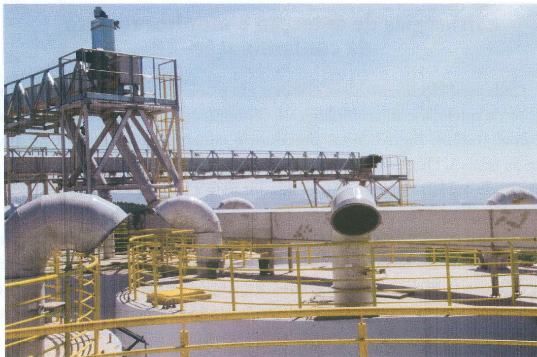
Figura 2. Sistema de exaustão de ar instalado em uma fábrica de ração.
