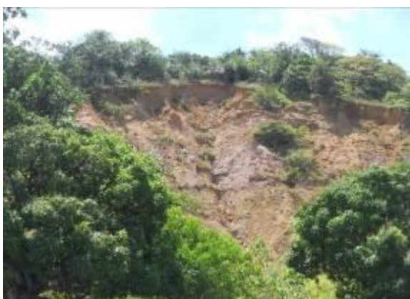
Figura 6. Deslizamento na encosta Foto: Anezia Maria Fonseca Barbosa
