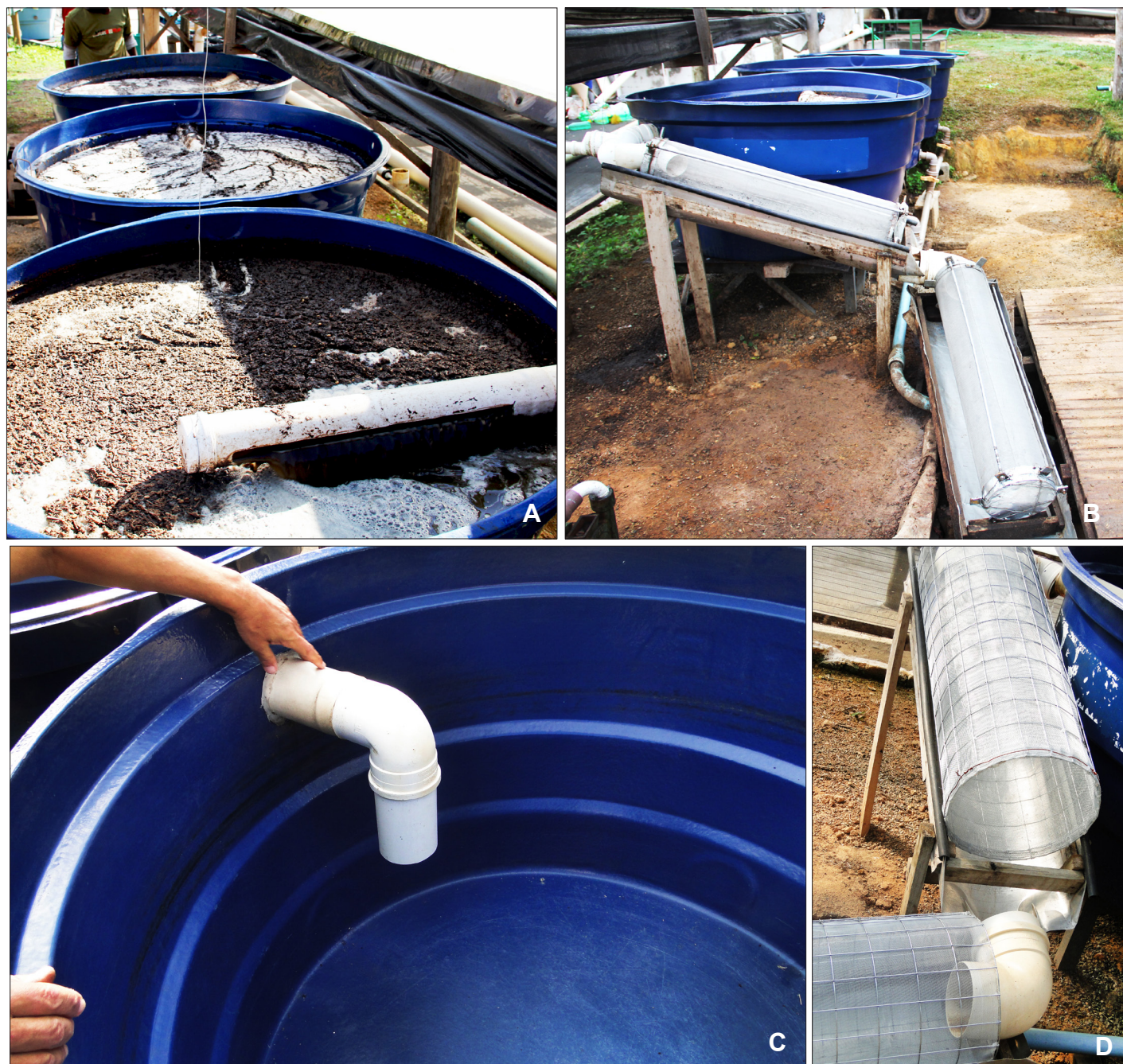
Figura 3 - Sistema de limpeza de águas residuárias
