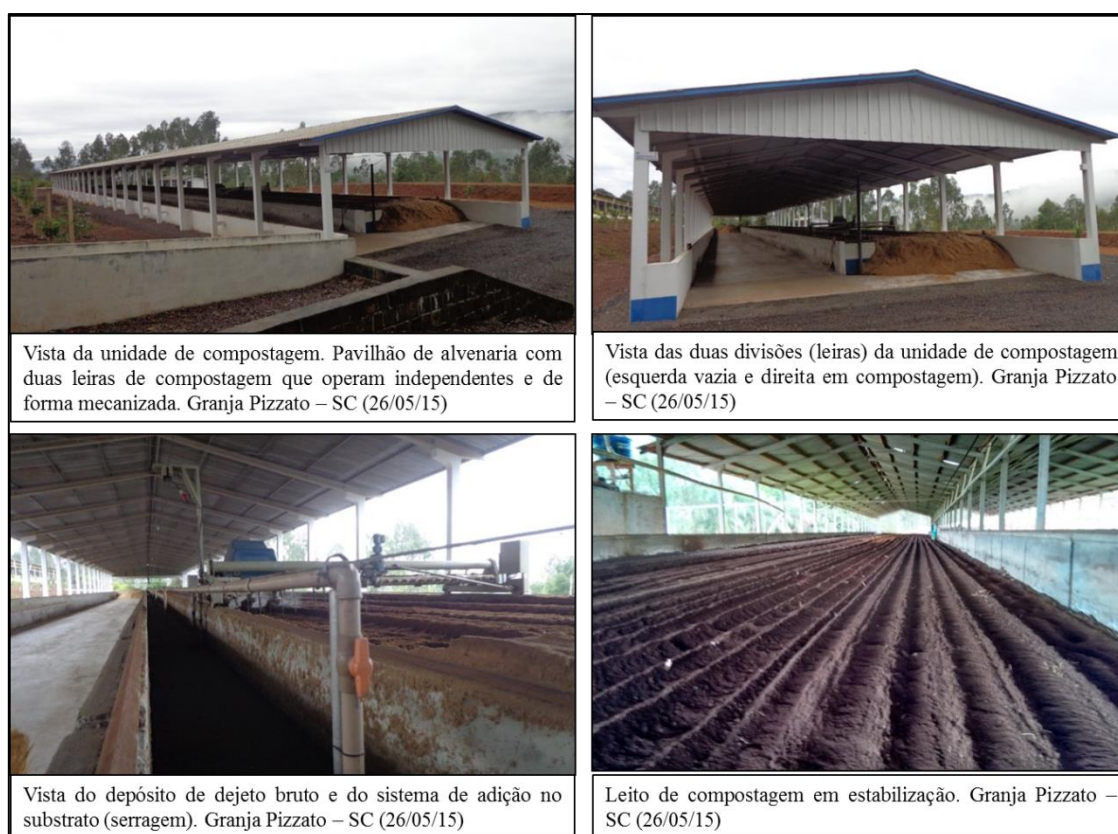
Figura 1. Alguns dos processos pertinentes à implantação da compostagem de dejetos em granjas de suínos.
