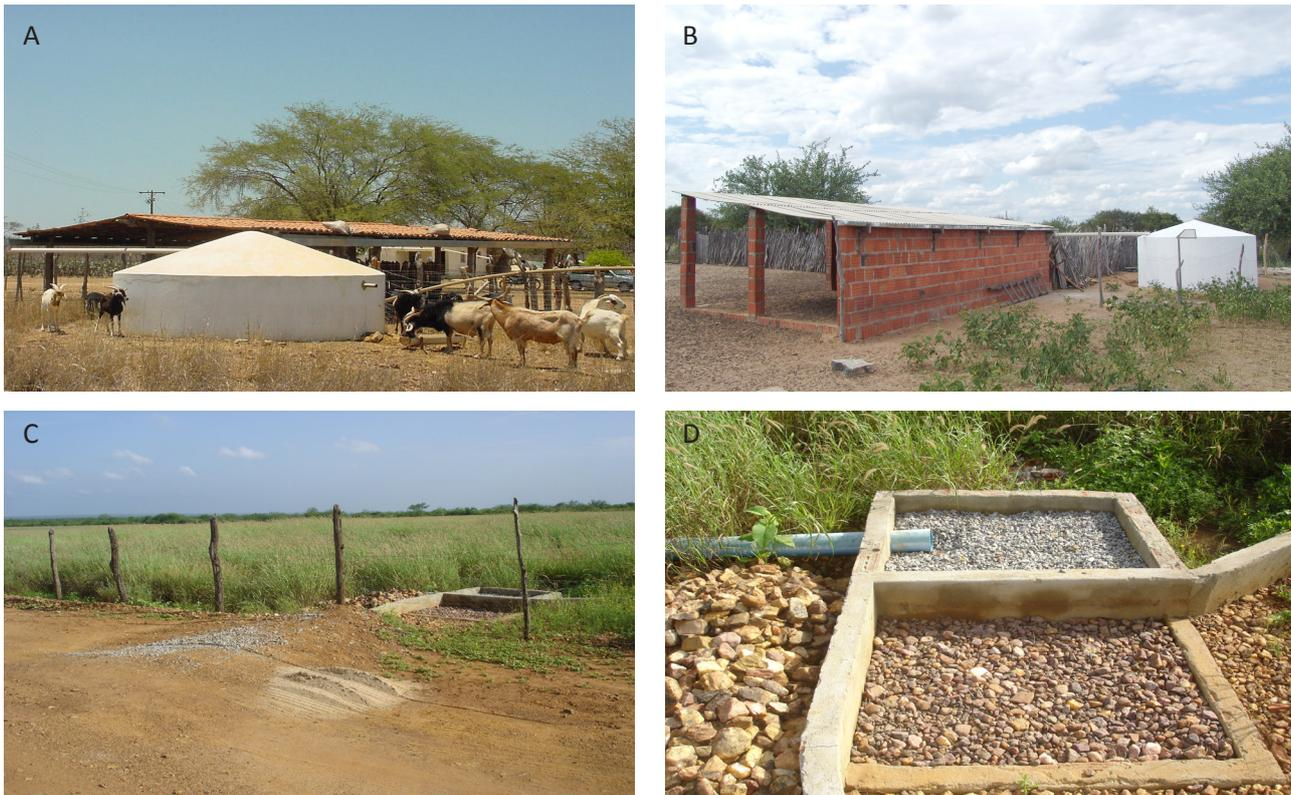
Figura 5. Cisternas de produção para atender aos caprinos e ovinos, instaladas no campo experimental da Embrapa (A), em área de produtor (B) e detalhes do sistema de filtragem (C) e bebedouro (D).
