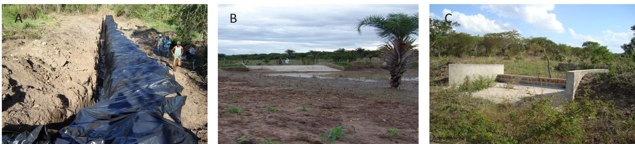
Figura 6. Vala impermeabilizada com lona plástica (A); barragem construída em linhas de drenagem com sangradouro (B); barragem subterrânea em funcionamento com seus principais elementos (C).
