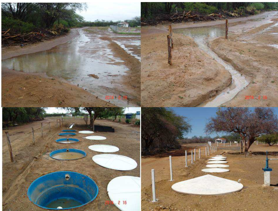
Figura 1. Vista parcial da cisterna de enxurrada com as caixas coletoras de água de chuva de estradas e caminhos.
