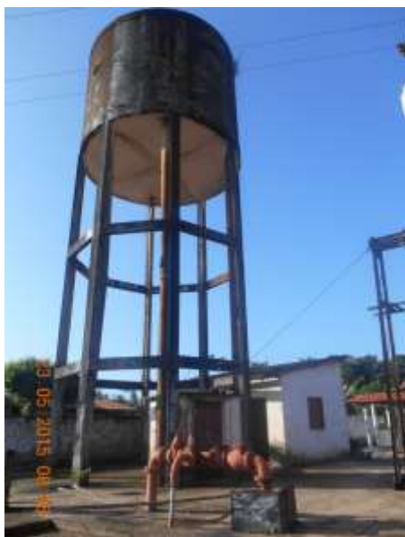
Figura 2 Primeiro microssistema de abastecimento da SAAE instalado em Igarapé-Açu.
