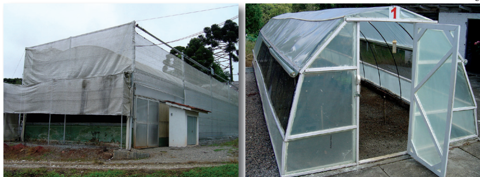
Figura 1. Casas de vegetação para enraizamento de estacas: automatizada (esquerda) e modelo rústico (direita).
