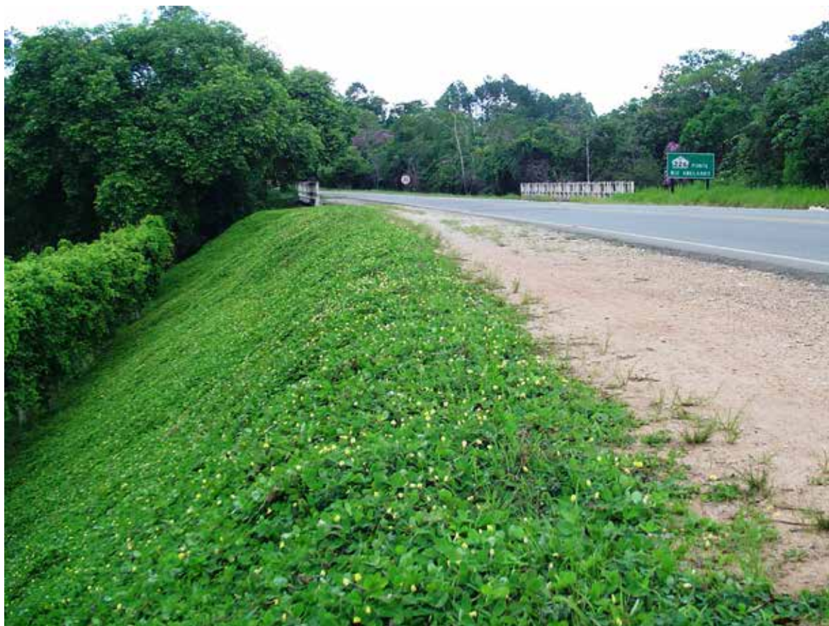
FIGURA 3. Arachis pintoii utilizado para conter erosão em talude. Foto: José F. M. Valls.
