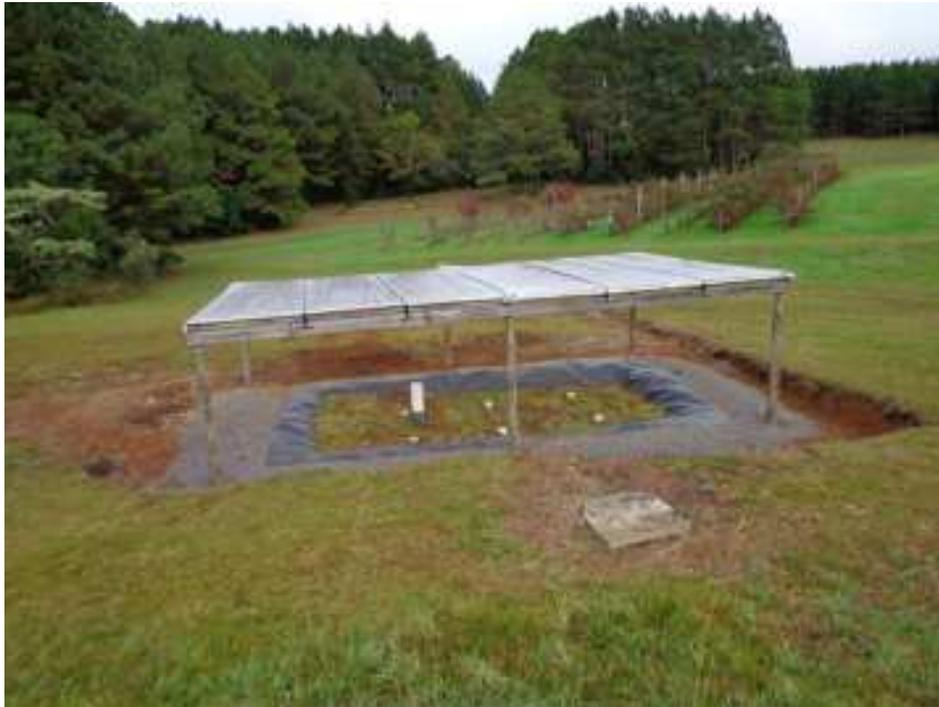
**Fig. 1.** Sistema Biobed Brasil para grandes volúmenes de efluentes.
