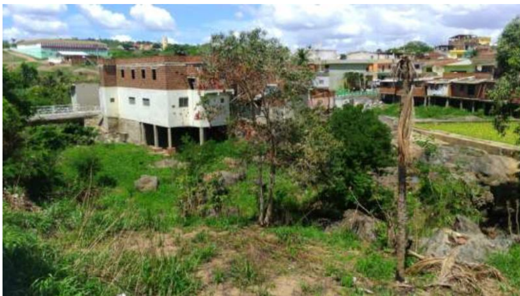
Figura 4: Construção civil irregular ao longo do leito do rio Tracunhaém. Fonte: SILVA, 2017.
