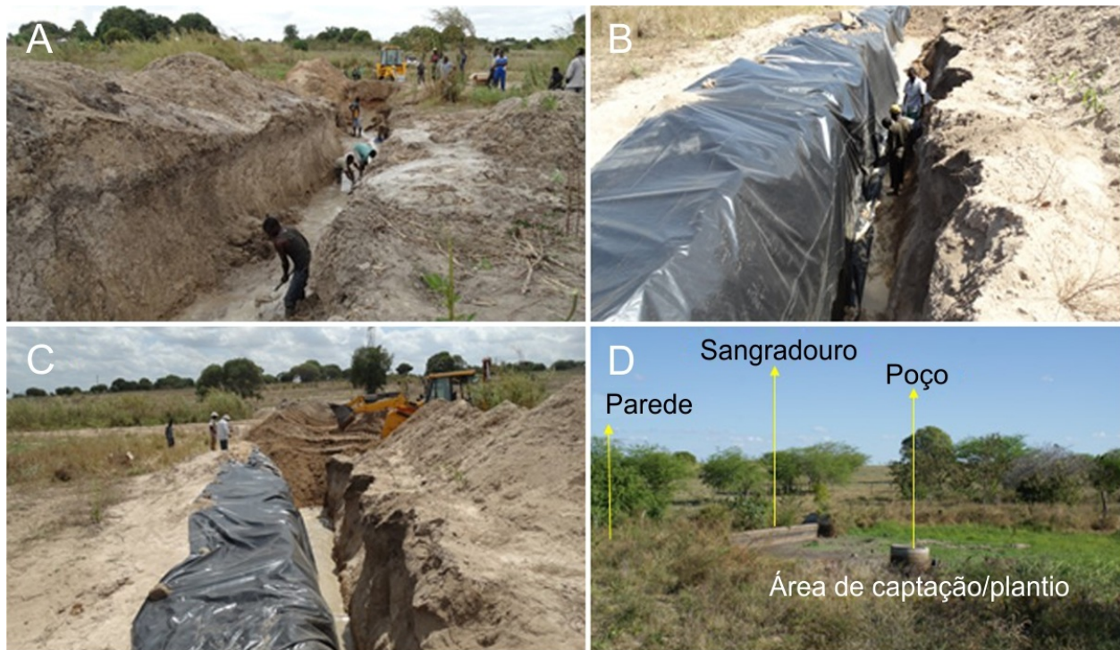
Figura 2. Abertura da valada da barragem subterrânea (A); chumbamento do plástico na vala impermeabilizando a parede (B); fechamento da vala (C); barragem subterrânea pronta, com parede, poço, sangradouro e área de plantio (D).
