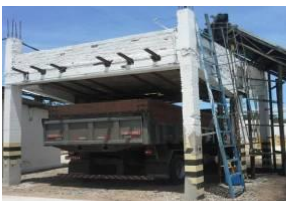
Figura 29 - Cascas descarregando no caminhão
