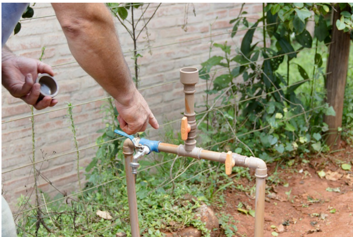
Figura 11. Clorador de fácil montagem e baixo custo.
