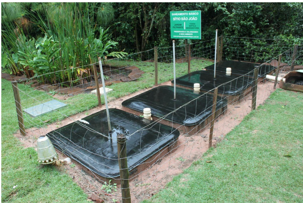
Figura 10. Vitrine da fossa séptica biodigestora para tratamento de esgoto doméstico.
