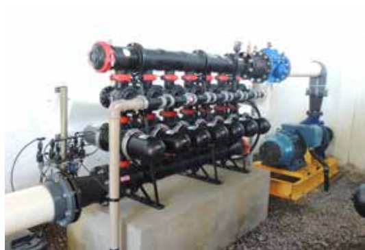
Figura 4. Bateria de filtros de disco com dispositivo de limpeza automatizada.
