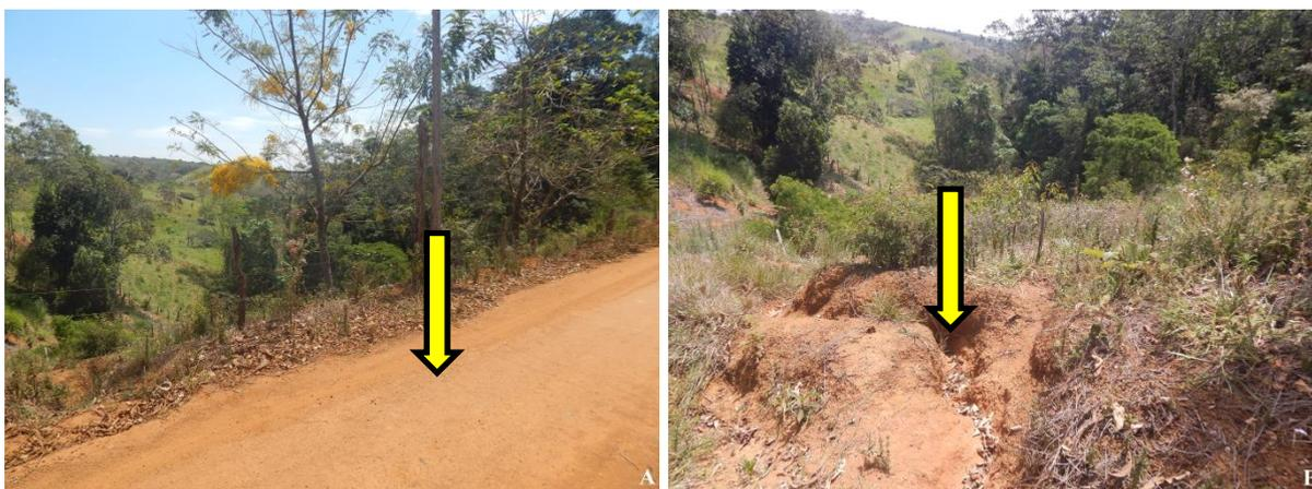
**Figura 18.** Estrada localizada em APP a montante de uma nascente perene da sub-bacia do Gaviãozinho-Ba, 2018. A - mostra a estrada localizada a montante da nascente nº67. B - mostra a erosão encontrada abaixo dessa estrada
