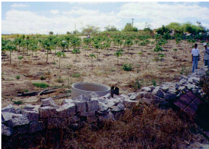
Figura 5 – Barragem submersa modelo Costa &amp; Melo, em Pernambuco
