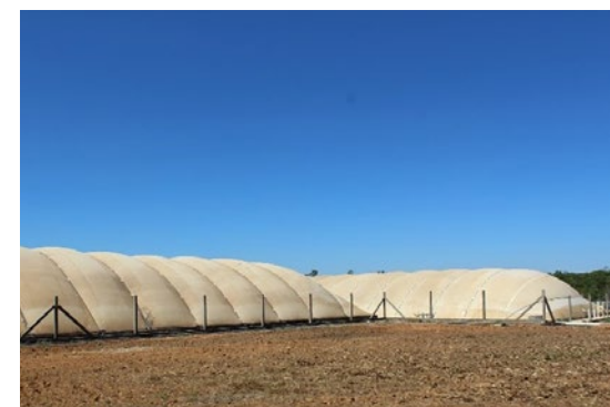
Foto 1. Biodigestores utilizados no tratamento de dejetos de suínos
