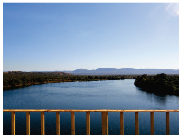
Figura 4.6 - Rio Tocantins e sua planície fluvial em paisagem monótona das extensas superfícies aplainadas, por vezes interrompidas por esparsas cristas quartzíticas isoladas. Ponte da rodovia TO-387, junto à cidade de São Salvador do Tocantins. Fotografia: Marcelo Eduardo Dantas, 2012.
