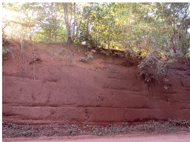
Figura 4.17 - Corte de estrada em de solo profundo, argiloso, de coloração e estrutura bastante homogêneas e boa fertilidade natural, derivado da decomposição química de basaltos da Formação Mosquito. Rodovia TO-134, entre as cidades de Luzinópolis e Angico. Fotografia: Juliana Maceira Moraes, 2011.
