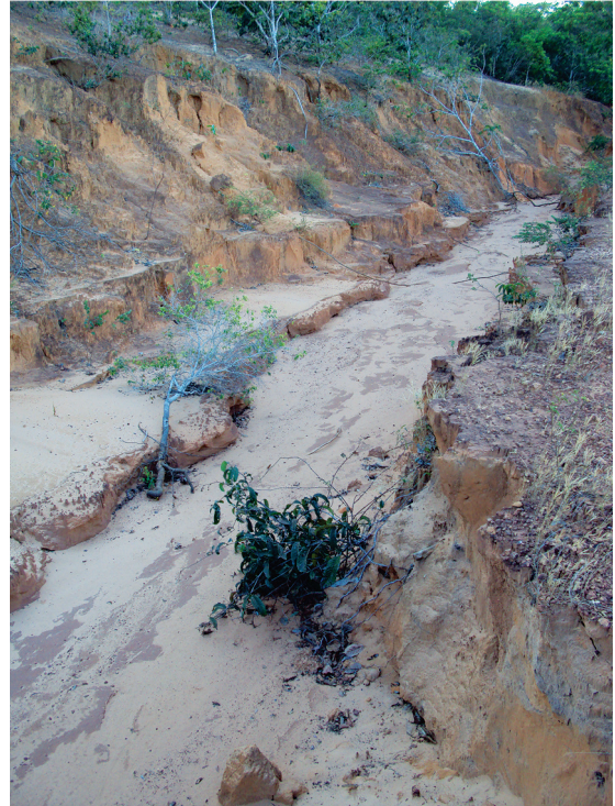
Figura 4.16 - Voçoroca gerada sobre solos muito friáveis e erodíveis (Neossolos Quartzarênicos), oriundos da intemperização dos arenitos de origem eólica da Formação Sambaíba. Rodovia TO-210, entre as cidades de Ananás e Angico. Fotografia: Juliana Maceira Moraes, 2011.
