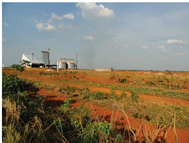
Figura 4.23 - Frente de expansão agrícola alcança os terrenos aplainados, sustentados por rochas metapelíticas da Formação Couto Magalhães, com ocorrência de Latossolos Vermelhos Distróficos, profundos e bem drenados. Rodovia TO-080, entre as cidades de Caseara e Marianópolis do Tocantins. Fotografia: Marcelo Eduardo Dantas, 2015.
