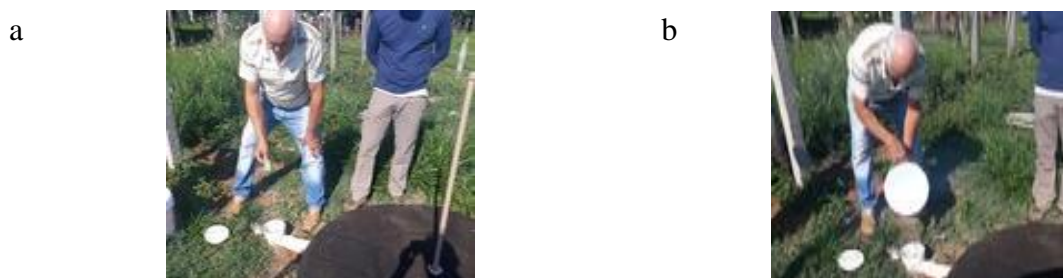
Figura 1. Imagens da inoculação da Fossa Séptica Biodigestora com bioativo comercial. (a) Colocação do sachê com inóculo e (b) adição de água para levar o inóculo ao sistema biodigestor.
