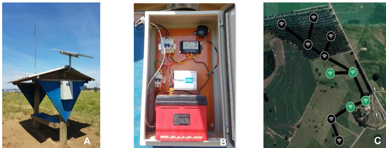
Figura 1. (A) Base autônoma de geração de energia fotovoltaica e antena para transmissão de dados de comportamento de bovinos de corte, em área de pastagem, instaladas sobre cocho de suplementação mineral. (B) No detalhe, circuito para armazenamento e fornecimento de energia elétrica, com quadro de comando composto por bateria, inversor e controlador de carga. (C) Mapa da área experimental indicando a estrutura atual da rede.
