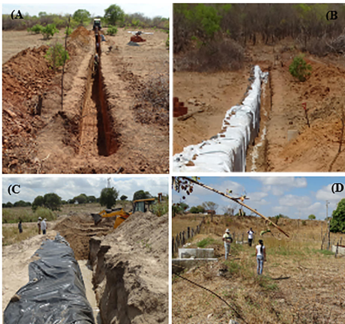
Figura 7. Barragem subterrânea submersível, modelo ASA (A – abertura, B- plástico estendido, C – fechamento da valeta, D – Barragem subterrânea pronta). Pedra, PE. Foto: Maria Sonia Lopes da Silva (2015).
