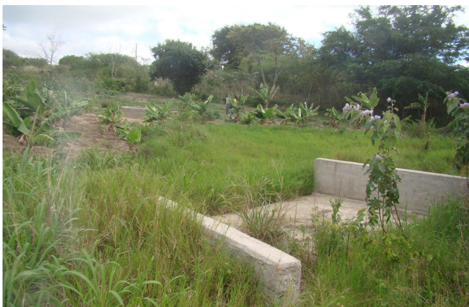
Figura 6. Barragem subterrânea submersível, modelo ASA. Pedra, PE. Foto: Maria Sonia Lopes da Silva (2015).
