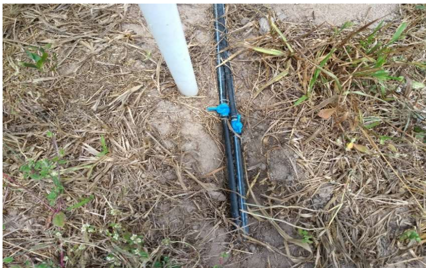
Figura 7 – Detalhe dos registros no início da linha do tratamento L4.
