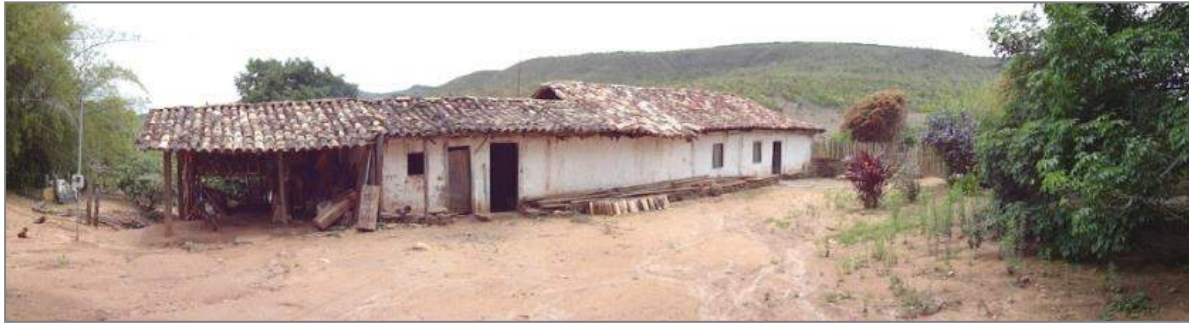
Foto 1: Casarão do Alto dos Bois – Angelândia/MG
