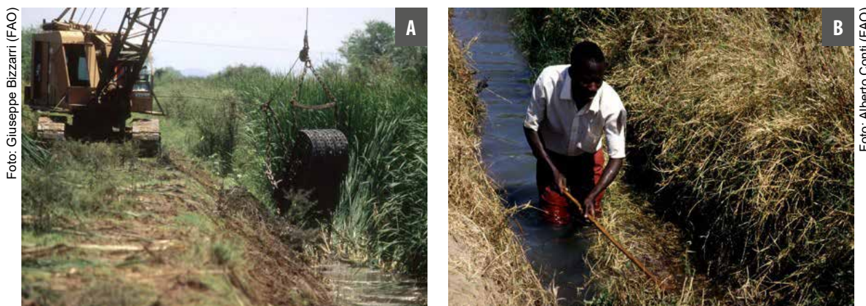
Figura 14. Limpeza de drenos e canais com máquina (A) e manual (B).
