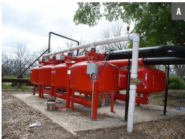
Figura 16. Bateria de filtros de areia de um sistema de irrigação localizada (A) e injetor de agroquímicos do tipo venturi (B).
