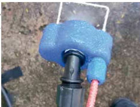
Molhamento e acúmulo de sujeira provocam curto-circuito pela fuga de energia entre eletrodo eletrificado e bico aterrado
