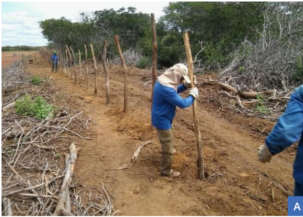
Figura 5. (A) Construção de cerca no entorno de área de jazida de piçarra para início do processo de revegetação. (B) Detalhe da cerca contendo oito fios de arame farpado. Notar que o espaçamento entre os fios deve ser reduzido na base da cerca. Ao fundo, detalhe de caixa de captação de águas pluviais.
