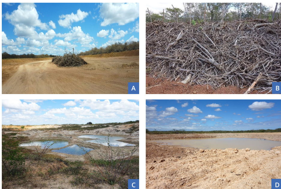
Figura 2. (A) Jazida de piçarra com cava rasa e plana. Notar ao centro da imagem a estocagem de galharia proveniente da vegetação suprimida da área. (B) Talude com deposição de galharia visando o controle da erosão. (C) Jazida de piçarra com cava profunda e irregular formando diversos pontos de inundação. (D) Cava de jazida de piçarra após a retificação de taludes e formação de bacia de inundação única.
