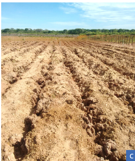
Figura 11. Etapas da aplicação do topsoil em jazida de piçarra. (A) Transporte e deposição do topsoil anteriormente à subsolagem. (B) Distribuição do topsoil anteriormente à subsolagem do terreno utilizando trator de esteira. (C) Área após a distribuição do topsoil e subsolagem.
