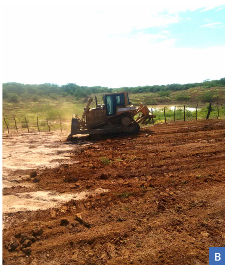
Figura 11. Etapas da aplicação do topsoil em jazida de piçarra. (A) Transporte e deposição do topsoil anteriormente à subsolagem. (B) Distribuição do topsoil anteriormente à subsolagem do terreno utilizando trator de esteira. (C) Área após a distribuição do topsoil e subsolagem.
