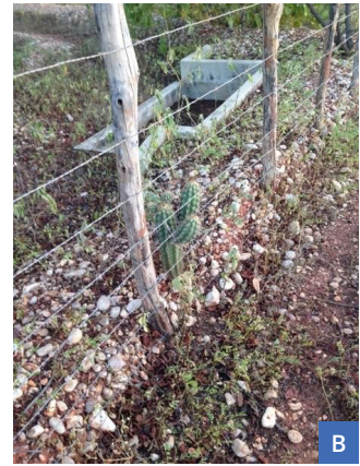
Figura 5. (A) Construção de cerca no entorno de área de jazida de piçarra para início do processo de revegetação. (B) Detalhe da cerca contendo oito fios de arame farpado. Notar que o espaçamento entre os fios deve ser reduzido na base da cerca. Ao fundo, detalhe de caixa de captação de águas pluviais.
